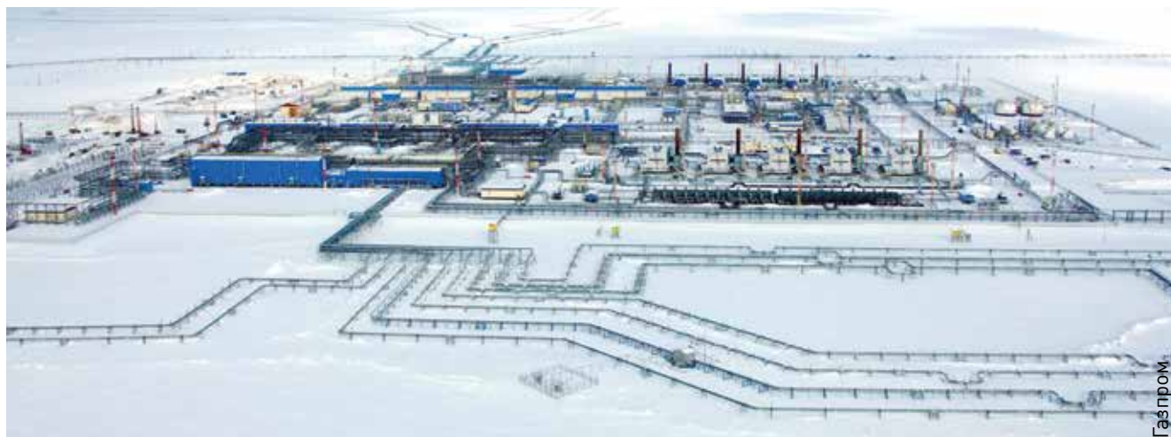
Газовый промысел № 2 Бованенковского месторождения
